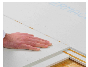
Collage des plaques avec des joints complètement remplis
