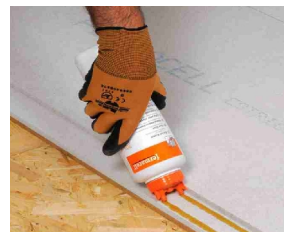
Application de la Colle pour Plaques de sol fermacell sur la battue.
