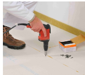
Fixation de la plaque à l'aide de vis...
