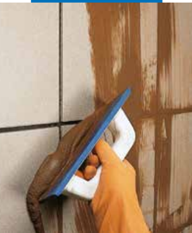
Jointoiment d'un mur extérieur avec une spatule
