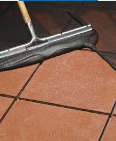
Jointoiment d'un carrelage en terre cuite avec une raclette
