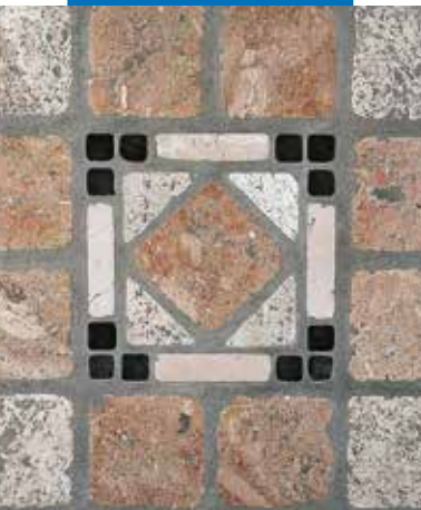
Jointoiement d'un vieux sol en marbre
