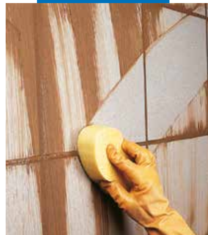
Finition de mur avec une éponge
