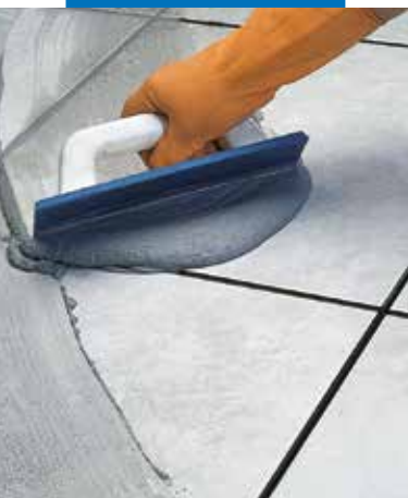
Jointoiment d'un carrelage céramique avec une spatule en caoutchouc pour joints
