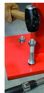
Fixation de structure métallique
