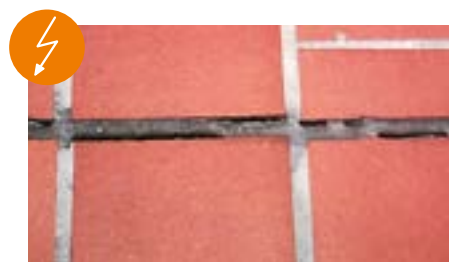
Les joints de mouvements Schlüter®-DILEX permettent d'éviter l'apparition de ce type de dommage.
